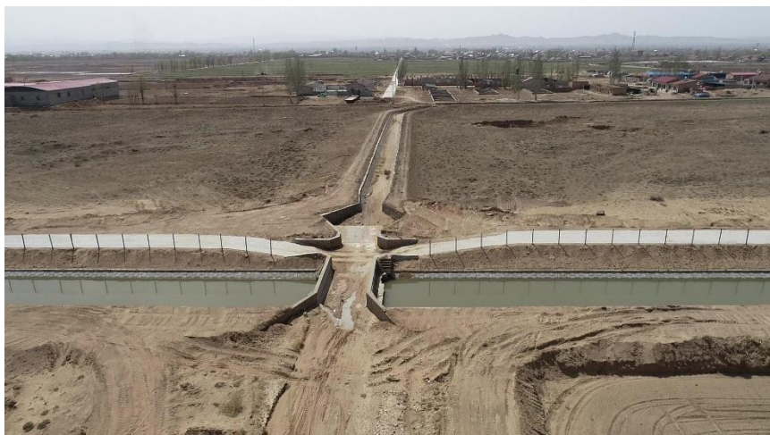
东二支排水渠下游段
