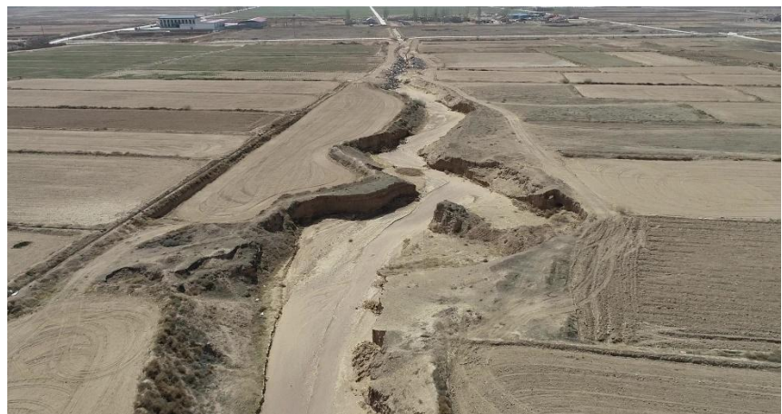
东二支排水槽上游段
